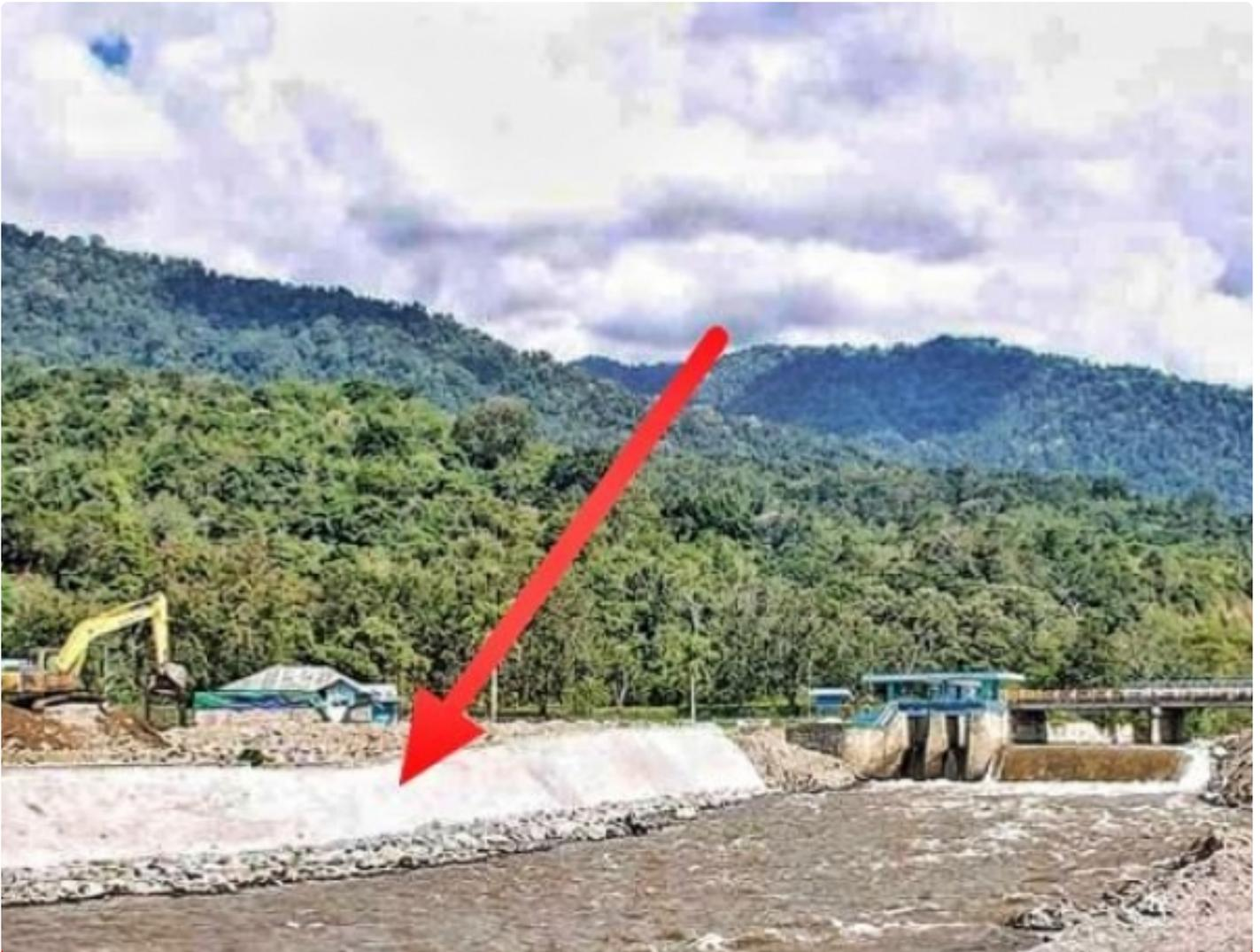
*Tanda panah merupakan ground sill untuk meredam kecepatan air dan mencegah adanya degradasi sungai*
